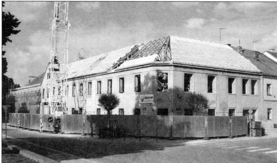
Probíhající tesařské práce na budově pošty na snímku z druhé poloviny srpna. Foto: Z. Pavlík
