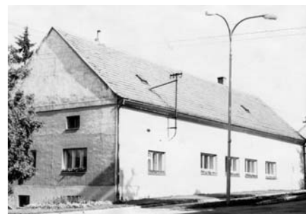
Pomocná budova, tzv. moštárna stála naproti škole (dnes zde stojí nová budova polikliniky)
