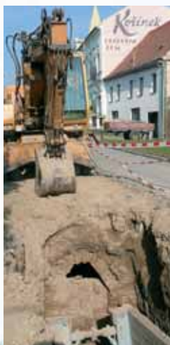
Zbytky chodby na Kolářkově nám. v r. 2006 Foto: B. Maleček
