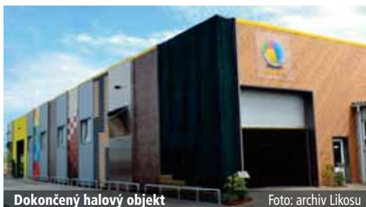
Dokončený halový objekt
