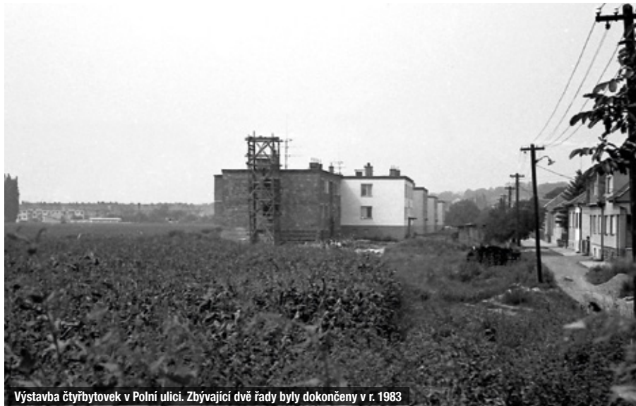
Výstavba čtyřbytovek v Polní ulici. Zbývající dvě řady bytů dokončeny v r. 1983
