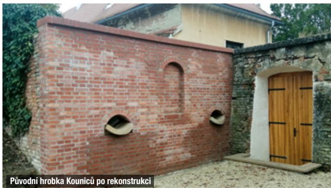
Původní hrobka Kouniců po rekonstrukci
