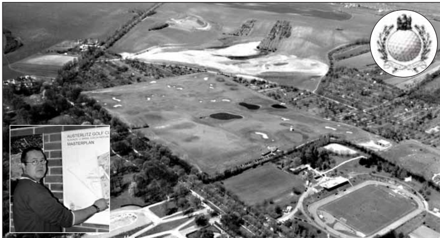
Na leteckém snímku je dobře vidět druhá část hřiště ve výstavbě. Na vloženém snímku ukazuje L. Grüber na plánu postup prací II. etapy. Foto: Mgr. František Maršálek a mab
