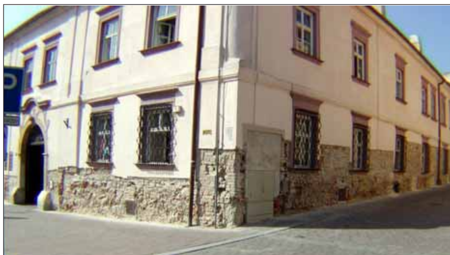
Oprava poškozených částí fasády Panského domu a protějšího domu (Česká spořitelna).
