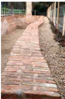
Zed' po opravě
