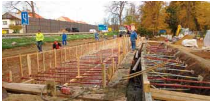
Oprava v místě původního stromu
