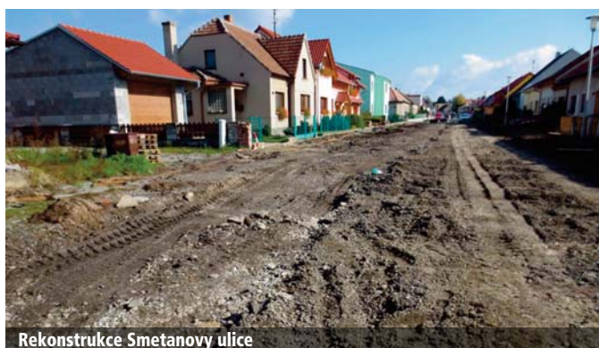
Rekonstrukce Smetanovy ulice
