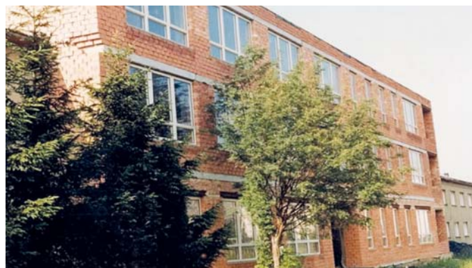
1988–1990. Nový pavilon v hrubé stavbě v přízemí budou dílny a na poschodích učebny.
