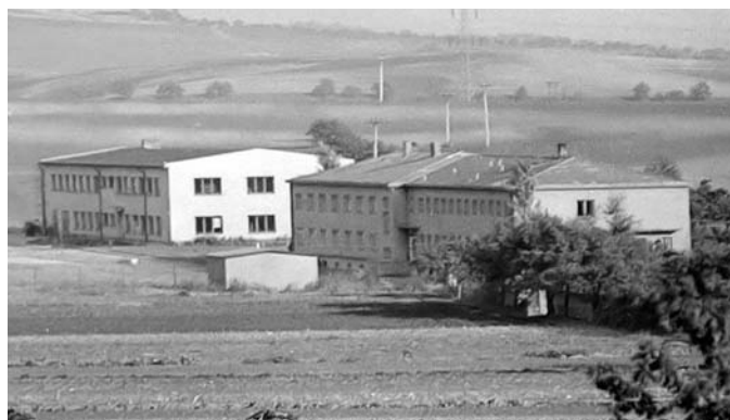
Celkový pohled na areál odborného učiliště
